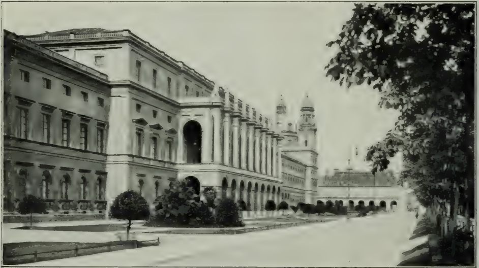
Résidence. Façade du Festsaalbau et Jardin de la Cour.
